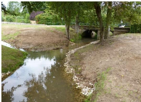
*Photo illustrant un exemple de banquette réalisée sur le Montgoger à Saint-Epain*
